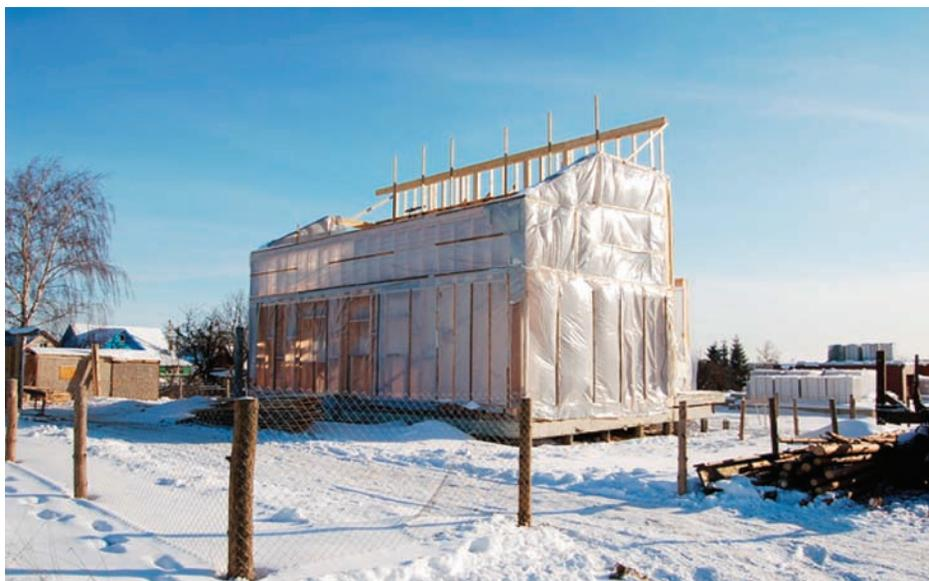
Рис. 3. Возведение каркаса второго этажа
