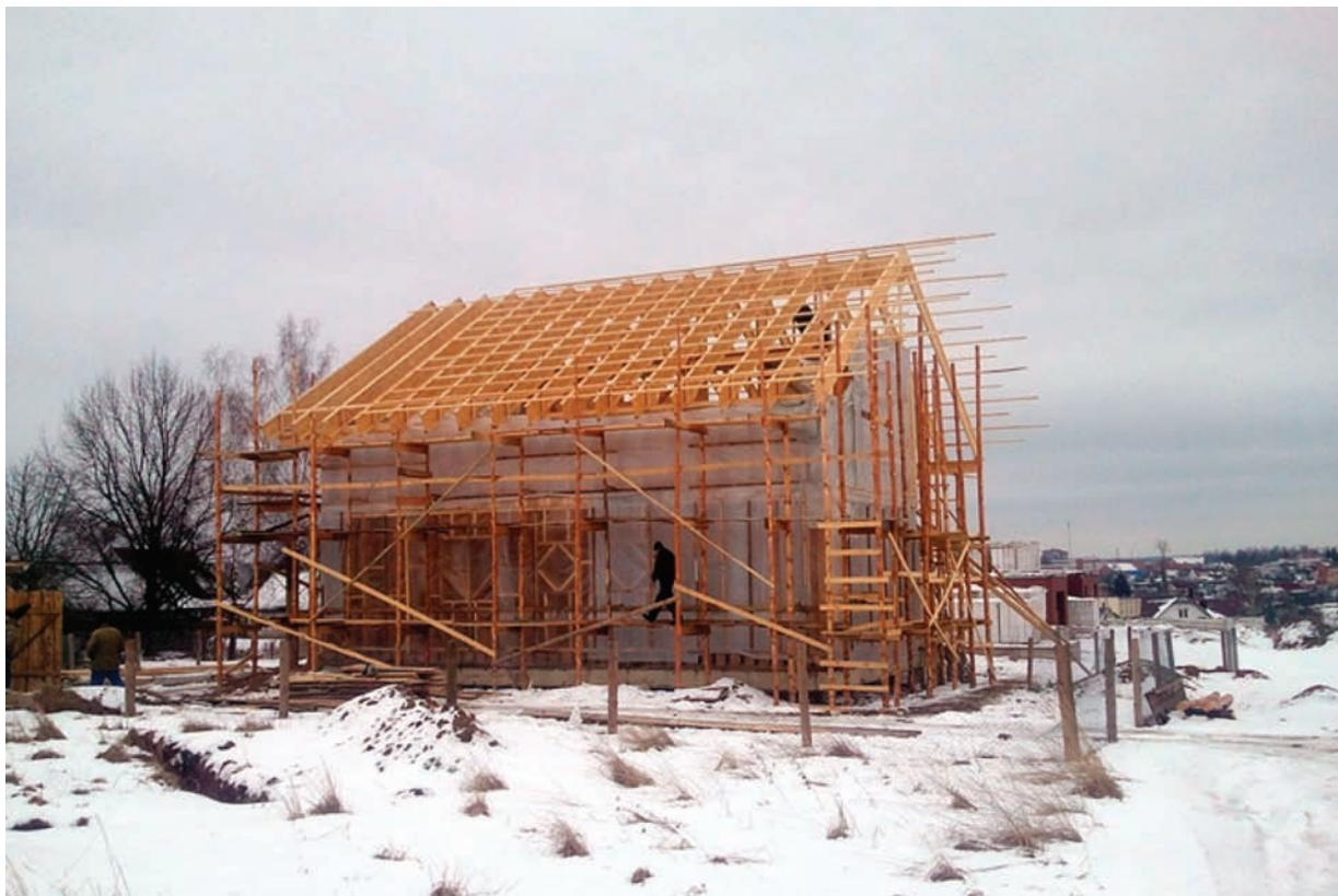
Рис. 6. Монтаж стропильной системы
