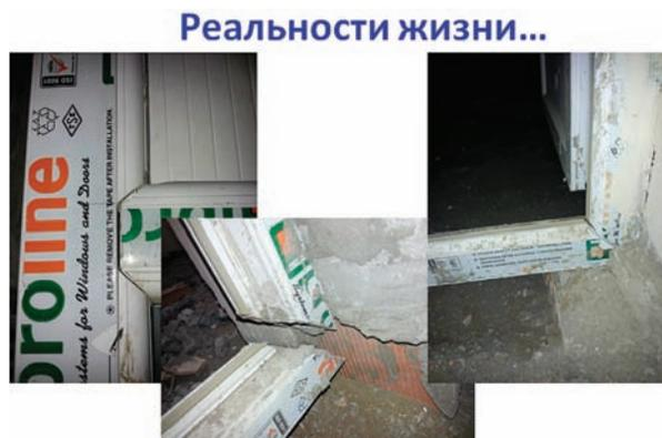
Рис. 6. Последствия неправильной установки окон
