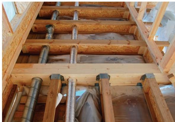
Рис. 5. Размещение системы вентиляции
