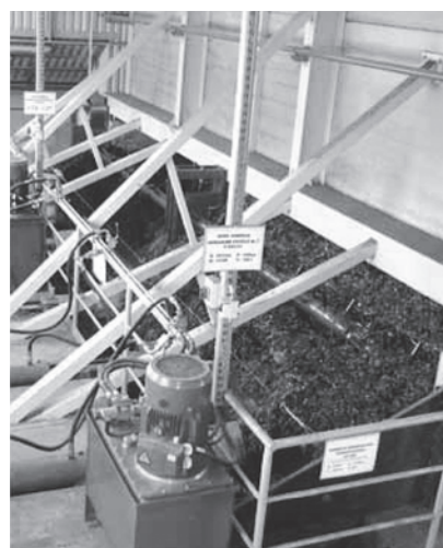
Рис. 1. Часть автоматического склада топлива. Виден горизонтальный рыхлитель топлива
