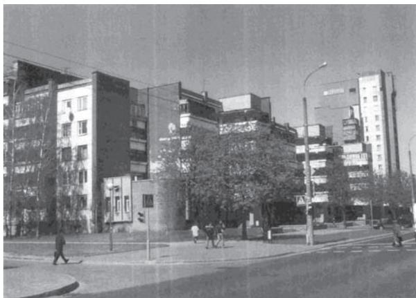
Рис. 4. Жилые дома с несущими стенами из кирпича и наружными из газосиликатных панелей двухрядной разрезки
