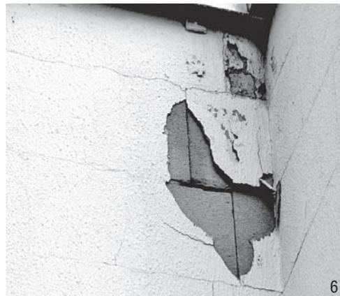
Наиболее распространенным дефектом является трещинообразование в виде сетки трещин с шириной раскрытия до 1,0 мм по защитно-декоративному покрытию и кладке стен из ячеистобетонных блоков, а также отслаивание защитно-декоративного покрытия, как правило, вместе со слоем ячеистого бетона. Указанные дефекты вызваны различного рода нарушениями в проектной документации, технологии производства строительных работ, что в конечном итоге в период эксплуа-
