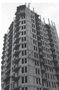
логии можно изготавливать от 280 до 400 м<sup>2</sup> качественных ровных стен в смену из полноценных строительных камней.
