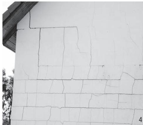
Рис. 2. Фрагменты разрушений стеновых ограждающих конструкций:
