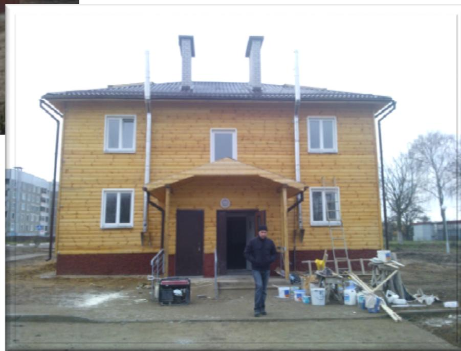
*ПРИМЕР ИСПОЛНЕНИЯ КАРКАСНО-ПАНЕЛЬНОГО ДОМА*
