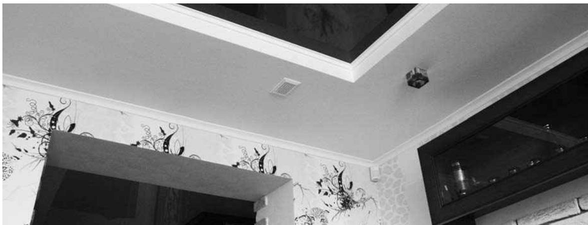
**Рис. 7.** Воздуховод, спрятанный в систему натяжных потолков
