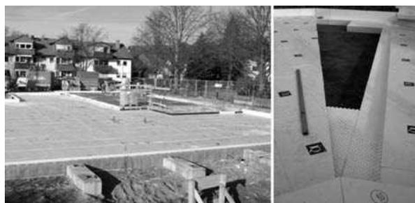
**Рис. 7.** Вариант теплоизоляции фундамента
