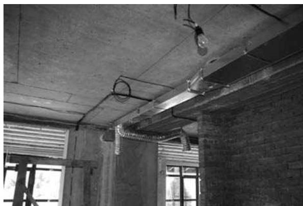
**Рис. 3.** Пример разветвления воздуховода
