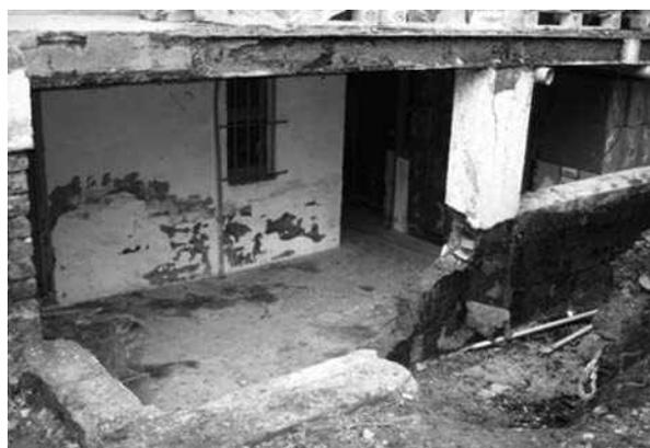
**Рис. 14.** Действие грунтовых вод на подвальное помещение
