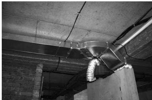
**Рис. 2.** Пример устройства воздуховода
