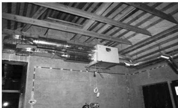
**Рис. 1.** Действующая система вентиляции с рекуперацией тепла
