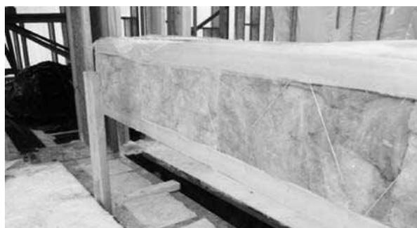
Рис. 7. Теплоизоляция мауэрлата
