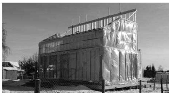
Рис. 6. Возведение каркаса второго этажа
