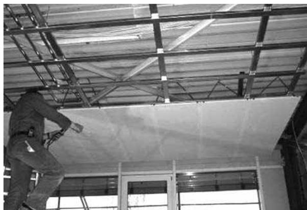
**Рис. 4.** Система потолочного отопления/охлаждения
