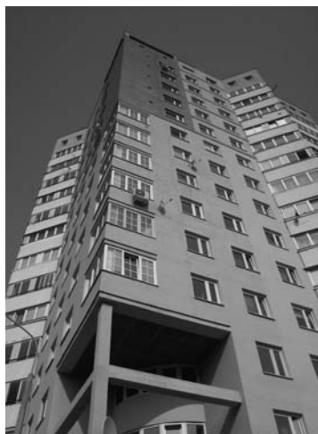
Фото 2. Жилой дом по пер. Калининградскому, 1
