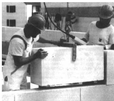
б) механизированный монтаж блоков на строительной площадке
