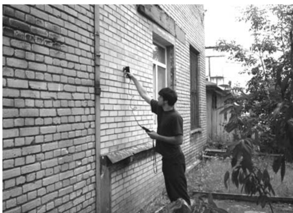
Фото 2. Фрагмент стеновой конструкции для испытаний в натуральных условиях
