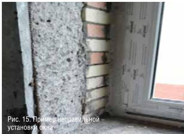
Рис. 15. Пример неправильной установки окна
