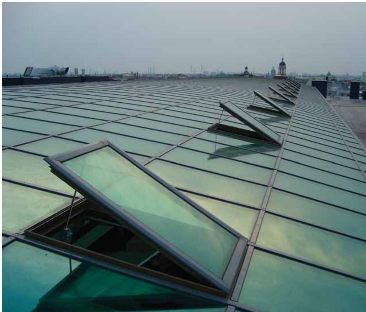
Рис. 1. Реечные приводы в здании ТЦ «Галерея»
