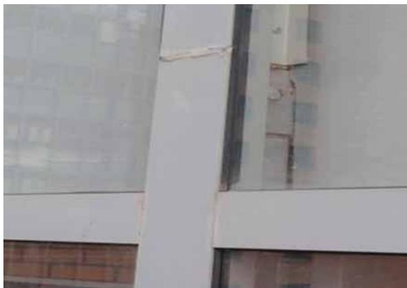
Рис. 18. Проблема протекания балконных рам
