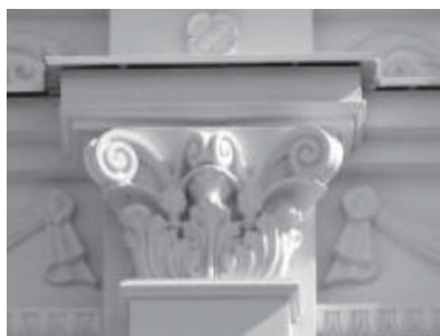
Здание детской филармонии в Минске – изготовление литых архитектурных элементов
