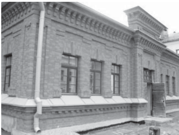
Здание конца XIX в. на территории больницы им. Клумова в Минске – реставрация кирпичной кладки
