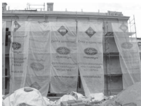
Здание бывшего монастыря монахов бернардинцев в Минске (реставрация и реконструкция под отель «четыре звезды») – saniрующие штукатурки
