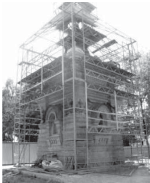
Каплица-усыпальница в дворцово-парковом ансамбле в Гомеле – реставрация кирпичной кладки
