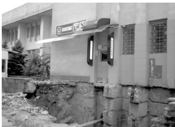
Рис. 1. Гидроизоляция фундамента в процессе эксплуатации здания
