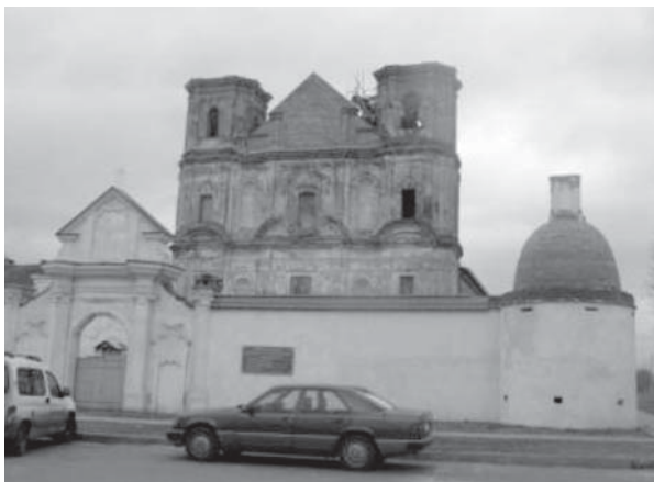
Здание бывшего иезуитского колледжума в д. Юровичи – решение проблем гидроизоляции, санации здания
