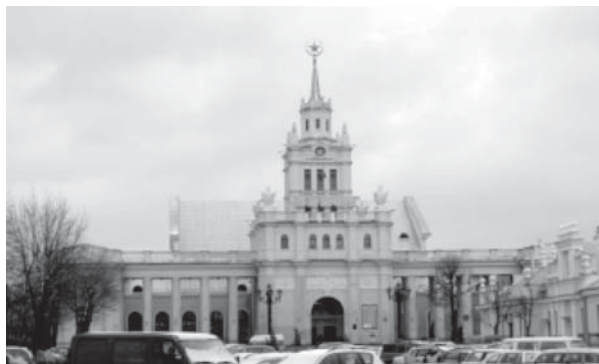
общий вид вокзала
