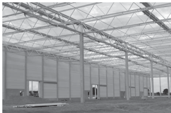
Рис. 2. Логистические центры. Стеновые панели из АЯБ на деревянном и стальном каркасах
