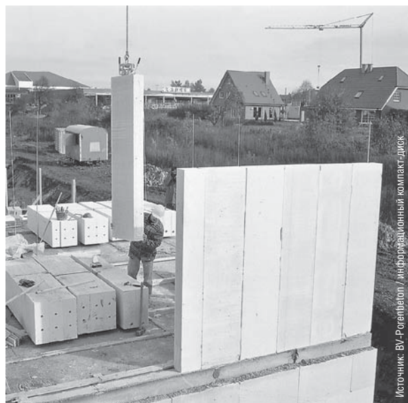
Рис. 3. Возведение внешних и внутренних стен из вертикальных панелей возможно при использовании минимальной рабочей силы
