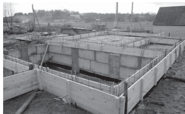
Рис. 10. Фундамент экспериментального жилого дома в процессе строительства: сверху – общий вид; внизу – фрагмент (с засыпанными пазухами) со стороны технического подполья
