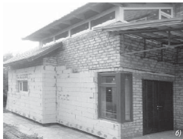
Рис. 3. Применение теплоизоляционных изделий D 150: а) утепление крыши, б) утепление фасада
