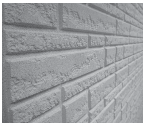
Рис. 3. Фасадные панели в применении (ДхШхТ – 2 м x 0,6 м x 35 мм)
