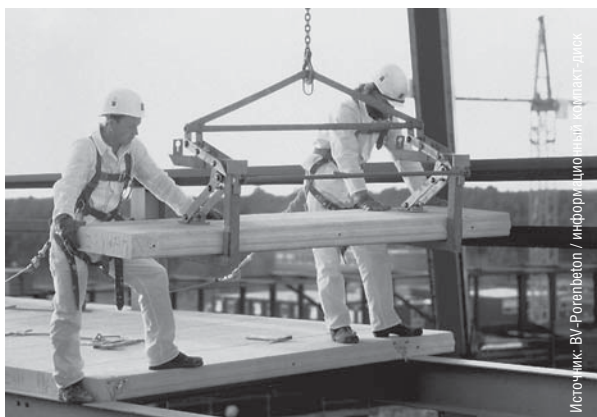
Рис. 2. Крупноформатные панельные элементы используются для кровли и междуэтажных перекрытий. Экономическая эффективность применения данных элементов ведет к снижению стоимости строительных работ
