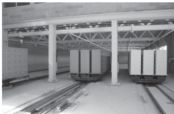
Рис. 7. Зона выдержки перед автоклавами, как и зона созревания, выполнена с более низкой высотной отметкой. Таким образом, на данном участке поддерживается высокая температура массива, что положительно сказывается на процессе запаривания и, как следствие, на качестве выпускаемой продукции
