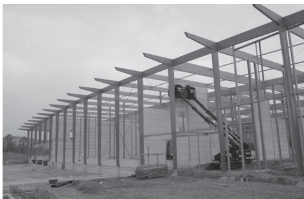
Рис. 2. Логистические центры. Стеновые панели из АЯБ на деревянном и стальном каркасах
