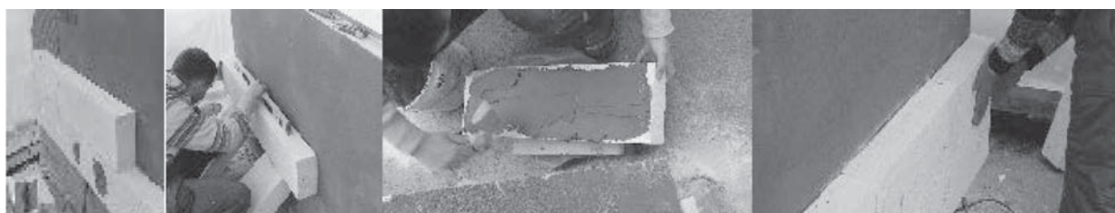
Рис. 4. Способы приклеивания теплоизоляционных плит
