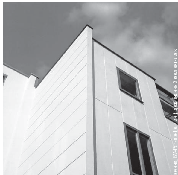
Рис. 1. Современный производственный цех – горизонтальная и вертикальная кладка стен выполнена из теплоизоляционных газобетонных панелей
