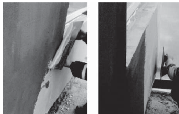
Рис. 6. Нанесение штукатурного слоя
