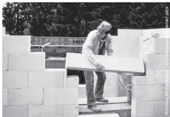
Рис. 4. Для возведения оконных и дверных проемов используются перемычки различной длины
