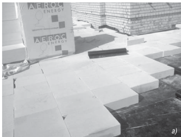
Рис. 3. Применение теплоизоляционных изделий D 150: а) утепление крыши, б) утепление фасада
