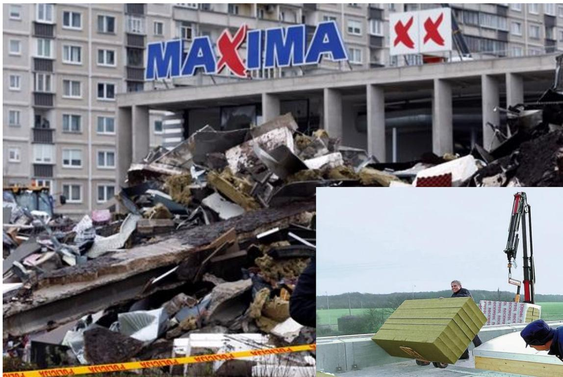
1 м<sup>2</sup> ISOPiR 100мм весит 3,5кг, а 1м<sup>2</sup> сопоставимой теплоизоляции из минеральной ваты толщиной 190мм весит около 25кг
