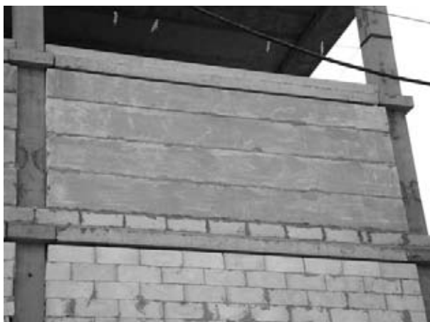
Рис. 6. Опирающие панели на полку ригеля каркаса дома
