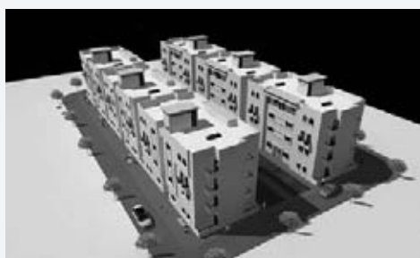
Рис. 4. Концепция 5-уровневого здания с использованием супергладких готовых панелей из газобетона и ПБАО
