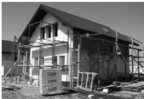
Рис. 2. Здание, построенное по энергоэффективному стандарту с применением газобетона
