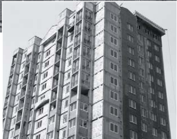
Рис. 3. 16-этажное жилое здание с поперечными несущими стенами из железобетонных панелей и продольными поэтажно опертыми наружными стенами из ячеистобетонных блоков
