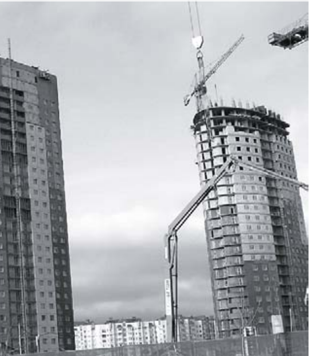
Рис. 2. Комплекс 25-этажных жилых домов с несущим каркасом из монолитного железобетона и поэтажно опертыми стенами из ячеистобетонных блоков в микрорайоне Каменная горка-1 в Минске
