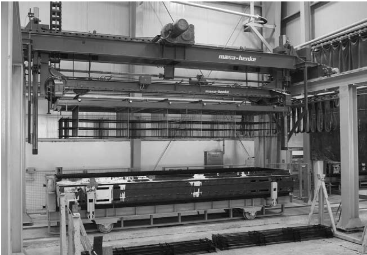
Рис. 3. Подготовленные рамы со стальными арматурными каркасами погружаются в газобетонную массу сразу после заполнения формы. Точное позиционирование арматурных каркасов особенно важно для качества конечного продукта
