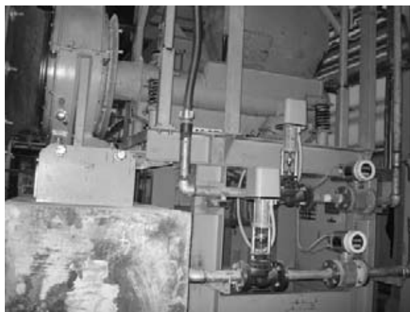
Рис. 10. При помощи двух отдельных дозирующих устройств (устройство измерения расхода вещества и регулировочный клапан) осуществляется точная дозировка (контроль пропорции) свежей воды и конденсата
